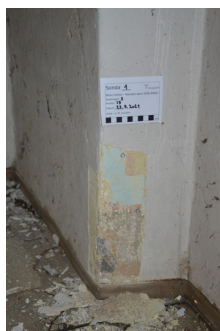
Slika: sonda (S 67) stena prostor 18 in sonda (S 69) cokol prostor 19. Sondi kažeta na morebitno prisotnost poslikave.
