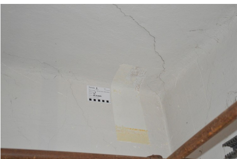
Slika: sonda (S 67) stena prostor 18 in sonda (S 69) cokol prostor 19. Sondi kažeta na morebitno prisotnost poslikave.
