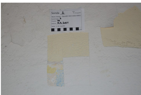
Slika: sonda (S 67) stena prostor 18 in sonda (S 69) cokol prostor 19. Sondi kažeta na morebitno prisotnost poslikave.
