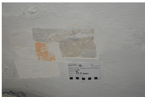
Slika: sonda (S 61) stena strop in (S 63) strop prostora 16 - Velike dvorane. Sondi kažeta na morebitno prisotnost poslikave.
