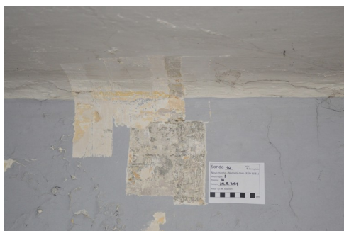
Slika: sonda (S 61) stena strop in (S 63) strop prostora 16 - Velike dvorane. Sondi kažeta na morebitno prisotnost poslikave.
