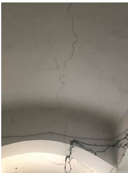
Slika: Razpoke na stropu hodnika (1.2).
